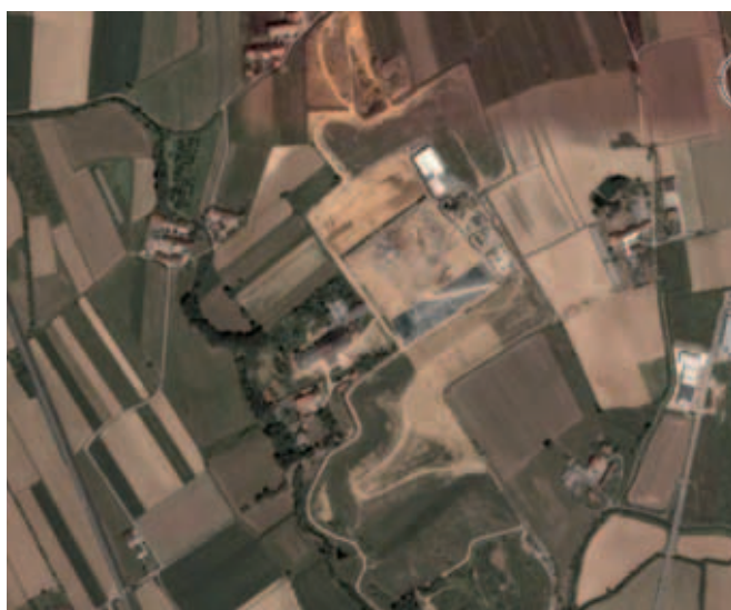
Fig. 7.2 – Foto satellitare della discarica di Chivasso, Regione Pozzo.
