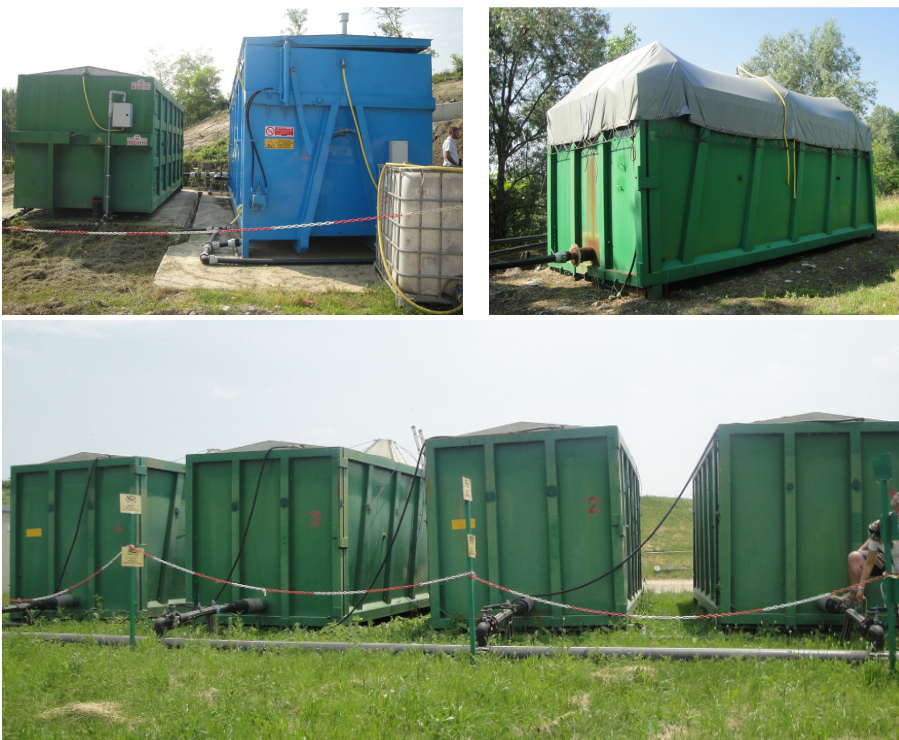
Fig. 5-5 – Biofiltri presso la discarica di La Loggia-COVAR 14 (in alto a sinistra), Collettero Giacosa-SCS (in alto a destra), Pinerolo-ACEA (in basso).
