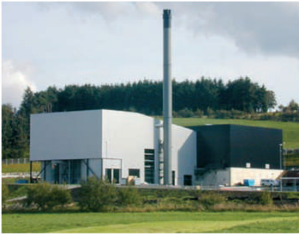
Impianto Energos di Forus Stavanger
