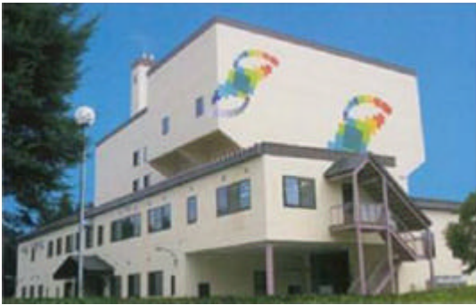
Chubu-Kamikita Clean Center
