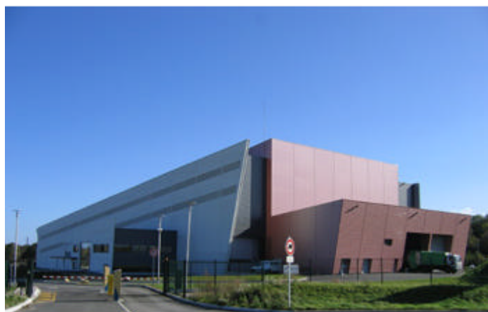
Fig. 5.10- Impianto Arthelyse di Arras, Thide Environnement
