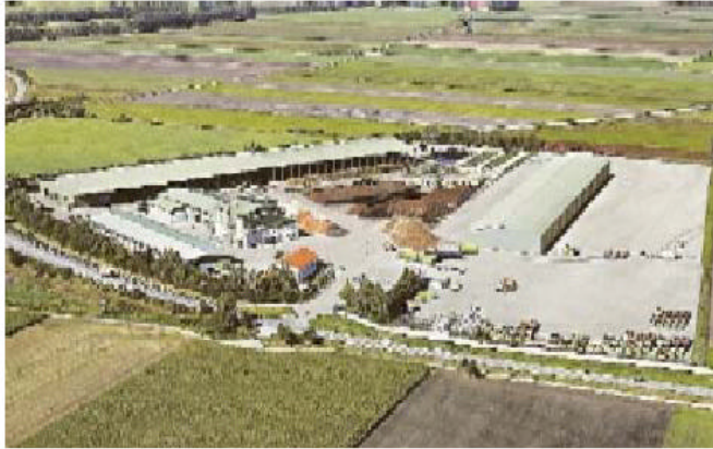
Fig. 5.23 – Pyromex Energy Ltd, Kompostwerk Eitting
