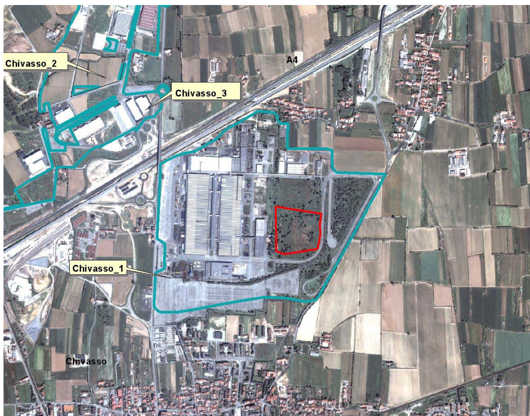
Fig. 4-5 - Foto aerea dell'area Chivasso_1 (volo del 2005).
