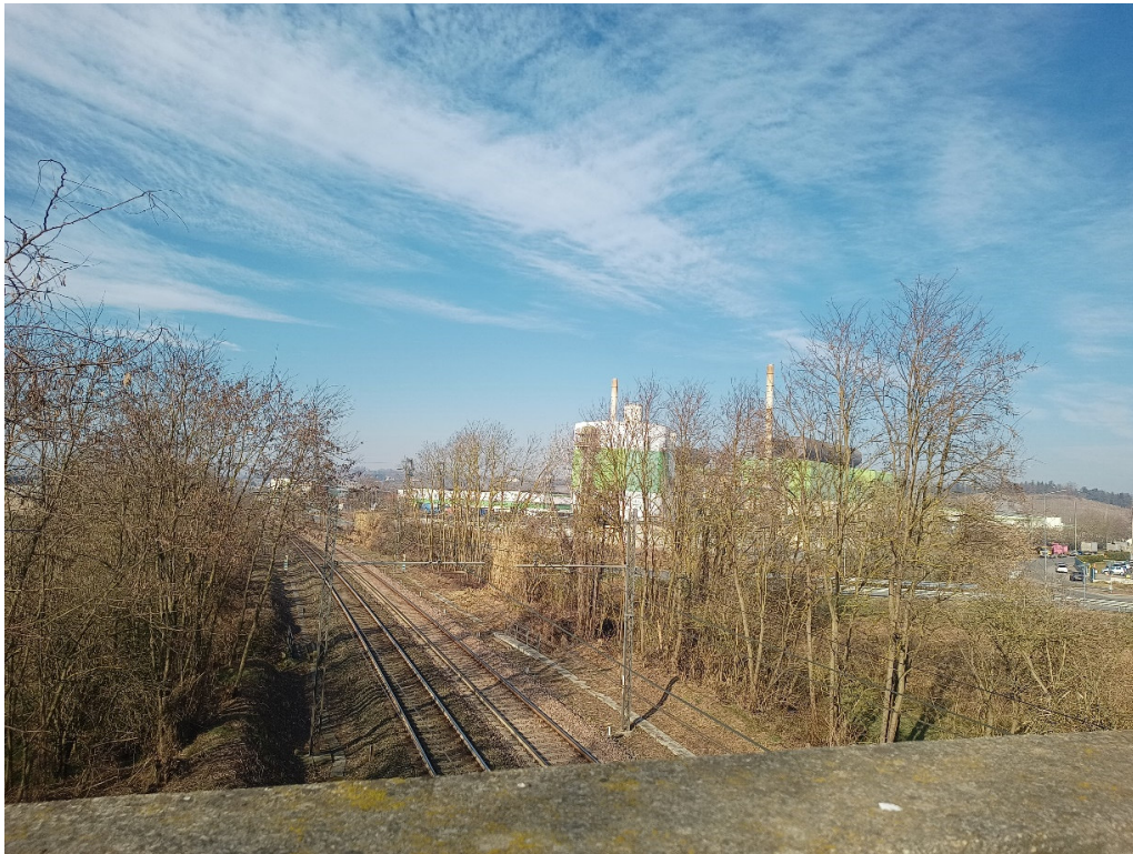
Ferrovia che costeggia il Sub comparto 5 (sullo sfondo la vetreria O-I Italy SpA)
