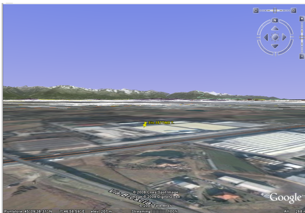
Fig. 10.32 - Immagine del sito di Settimo Torinese in direzione nord
