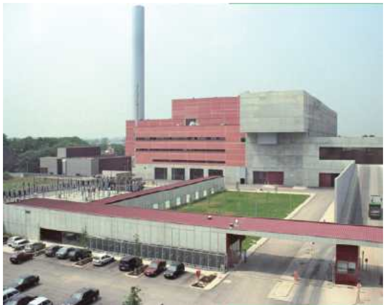
Impianto Silla 2, Milano – Italia, 450.000 t/anno
