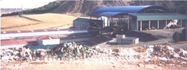
Fig. 18 - Impianto Horstmann a Valladolid, Spagna [1].
