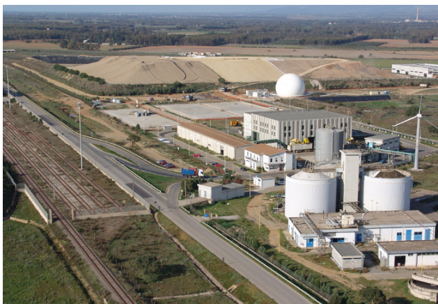
Fig. 8 – Impianto BTA a Villacidro (CA), Italia [8]
