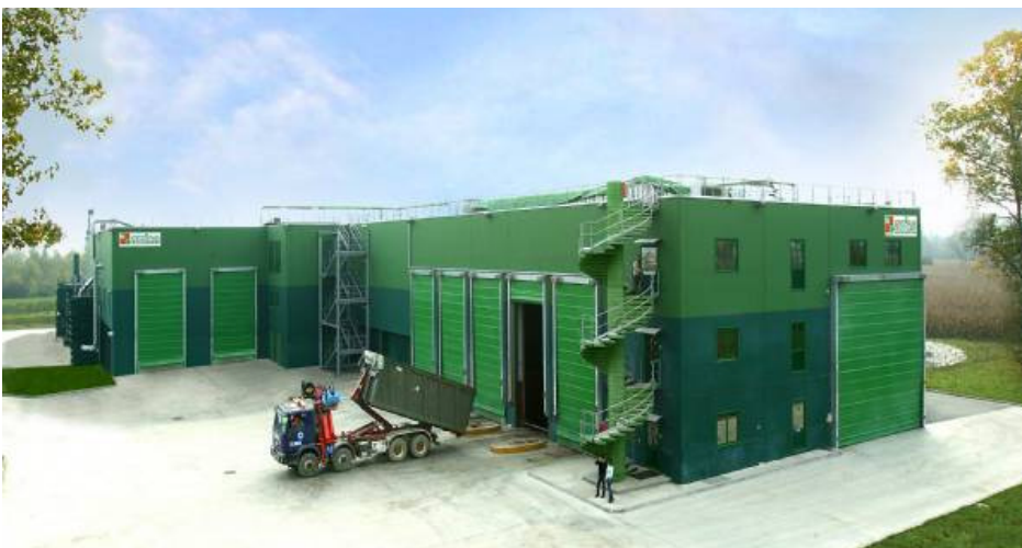
Fig. 6.1 – Impianto Ecodeco, Villafalletto (CN), Italia [88]
