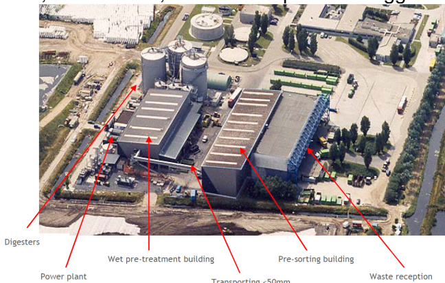
Fig. 28 - Impianto SBI FRIESLAND Heerenveen, Paesi Bassi [1].
