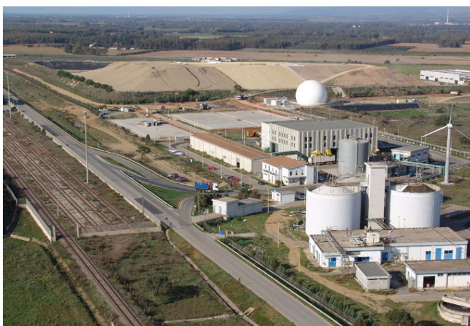
Fig. 6.14 – Impianto BTA a Villacidro (CA), Italia [94]
