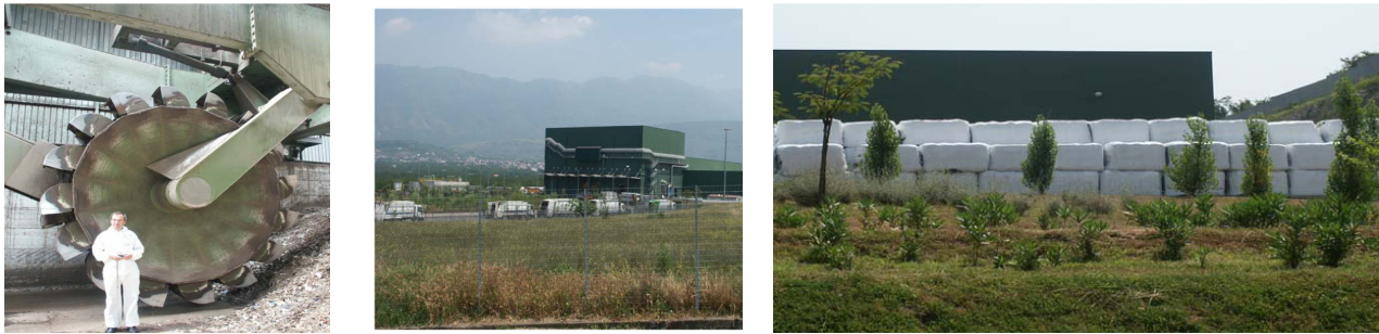
Fig. 35 - Impianto di Tufino: macchina rivoltatrice brevettata "CTM" (a sinistra), vista dell'impianto (al centro), CDR in balle (a destra).
