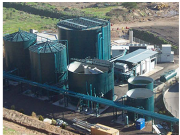
Fig. 6.11 - Sezione di separazione idro-meccanica e digestione anaerobica nell'impianto Arrow Bio [52]
