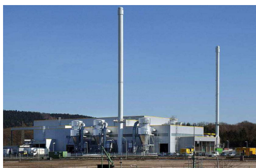
Fig. 16 –Impianto di Osnabrück (Germania) [10]
