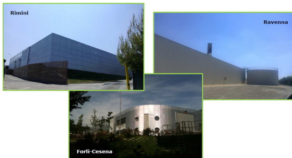
Fig. 3.12 – Impianti di digestione anaerobica di Hera (tecnologia Bekon).
