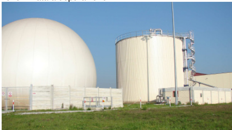
Fig. 5.6 – Impianto di digestione anaerobica di Camposampiero (PD).
