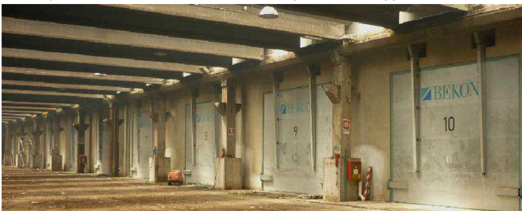
Fig. 5.14 – Digestori di Voltana di Lugo (10 digestori)
