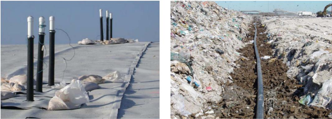
Fig. 5-2 – Pozzi verticali di iniezione (a sinistra) e trincee orizzontali (a destra)
